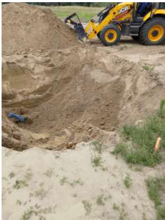
Fot. Brak zabezpieczeń wykopów
