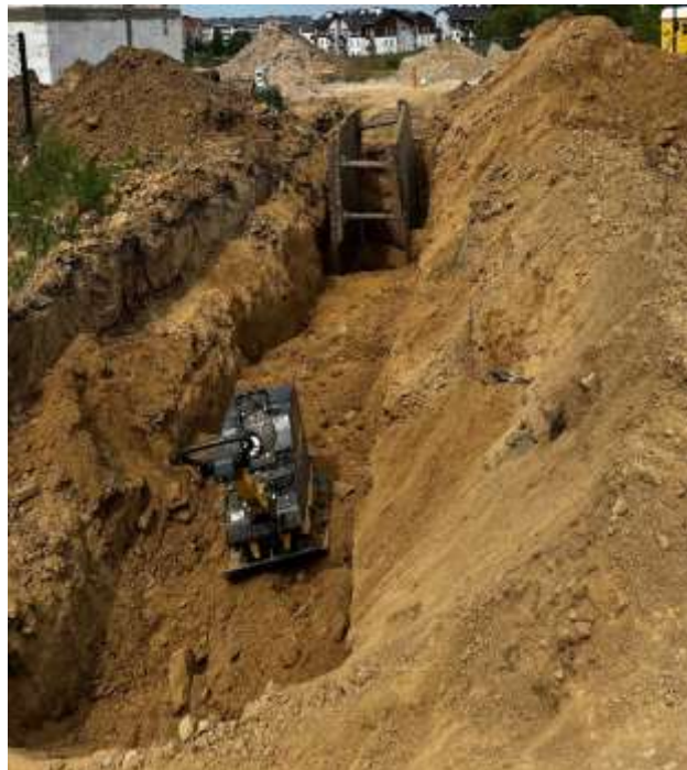
Fot. Brak zabezpieczeń wykopów
