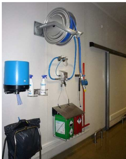
Stacja mycia maszyn i podłogi hali produkcyjnej. Pracownik upoważniony i przeszkolony wymienia dwa zbiorniki (zielony i czerwony), które dostarczane są z magazynu środków chemicznych
