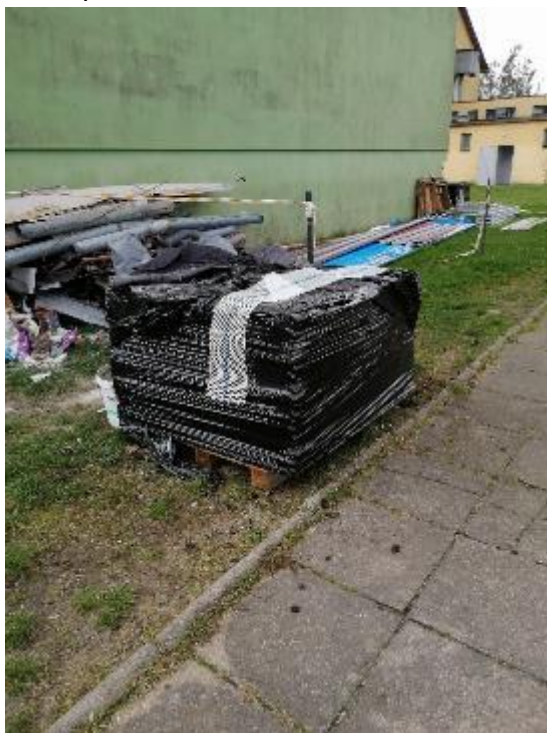
Brak oznakowania składowanych odpadów azbestowych znakiem ostrzegawczym „Uwaga zawiera azbest”.
