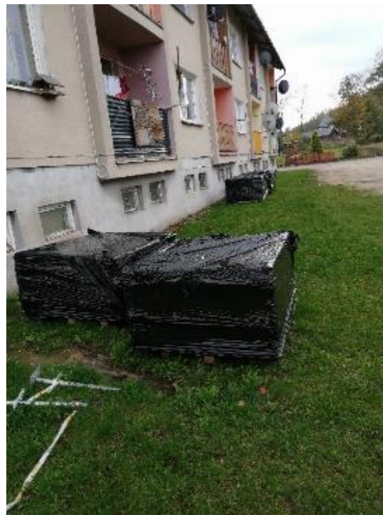
Brak oznakowania składowanych odpadów azbestowych znakiem ostrzegawczym „Uwaga zawiera azbest”.
